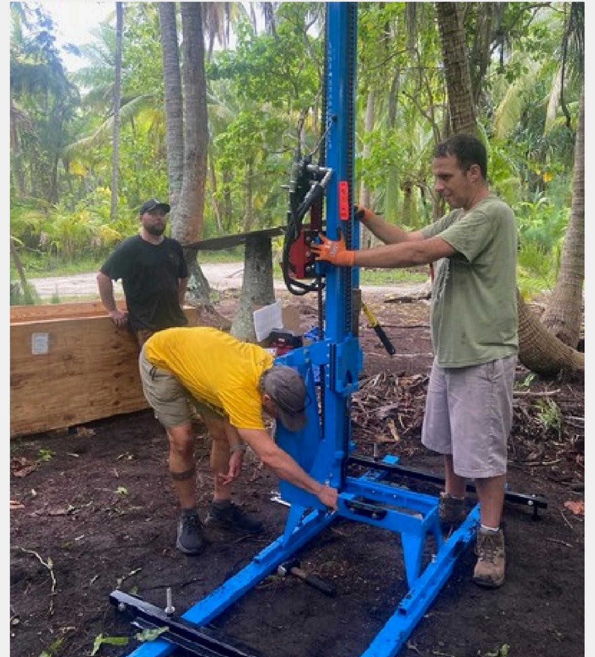
Installation d'un piézomètre pour l'étude des eaux souterraines
